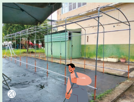
圖17、搭建網室骨架
