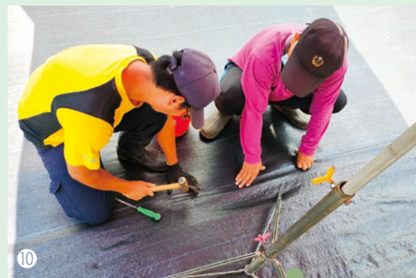
圖1、大樹國中溫室 圖2、大樹國中溫室農場 圖3、進行場勘 圖4、育苗網室預定場地 圖5、鋪設抑制席的雜草抑制的很好 圖6、縫隙間仍有雜草長出 圖7、網室規格為10m(長)、2.2m(寬)、2.5m(高) 圖8、施工前先把原有抑制席上的雜草去除 圖9、將不平整的區域雜物移除後即可進行鋪設抑制席 圖10、每個重疊釘合的抑制席都有30公分做拉撐，不易有接縫外露的問題。 圖11~12、接縫外露，雜草就會撐開抑制席。
