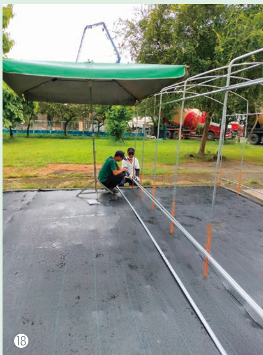
圖17、搭建網室骨架
