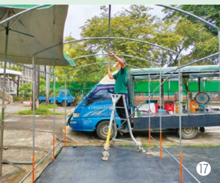
圖13、使用固定釘進行固定
